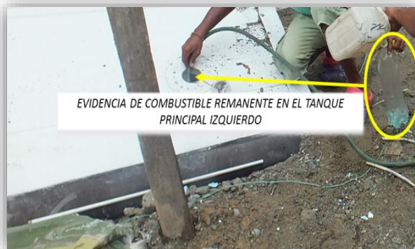
remanente de combustible drenado del plano izquierdo
